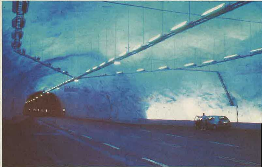
VÄNDPLATS. På tre ställen öppnar sig tunneln till ett stort bergtrum upplyst i vackra blå och gula färger. Har man tunnelskräck kan man faktiskt vända här och köra tillbaka.
