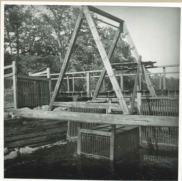
a. Laxbåda med nygfundningsverk. H.F.-m. T.v. en nyghissad båda.
