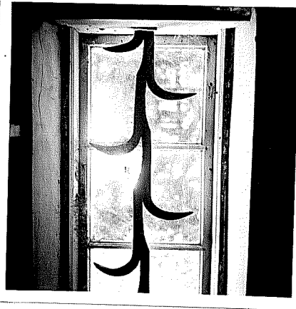
N:r 3. Gammelt fönster i H. N:s hus.
