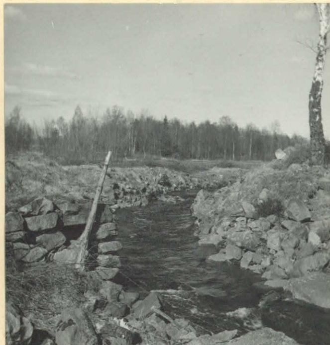
Foto från byvägsbron mot kvarnplatsen. Stenmuren till vänster är en del av kvarnhusgrunden. Från denna sträcker sig en cirka 100 m lång dammvall bort genom buskaget i bildens vänstra kant. De vallar som syns utmed ån är dikesvallar efter sista rensningen.
