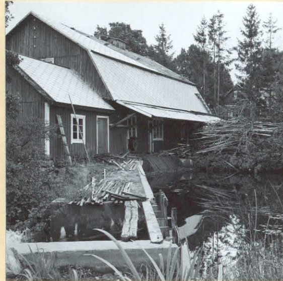
Kvarnen sedd från dammvallen. Under snedtaget finns såg- bänken. I dammvallen syns den stora utskovsluckan. Foto sept. 1957.
