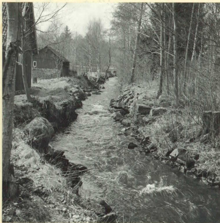
Foto österifrån upp genom kvarnområdet. Grundmurar efter kvarnbyggnader syns till höger om ån; ytterligare flera murlämningar finns bland träden längre bort. Anton Kris- tianssons stuga och uthus syns till vänster. Längst bort skymtar landsvägen och bron. Foto april 1954.
