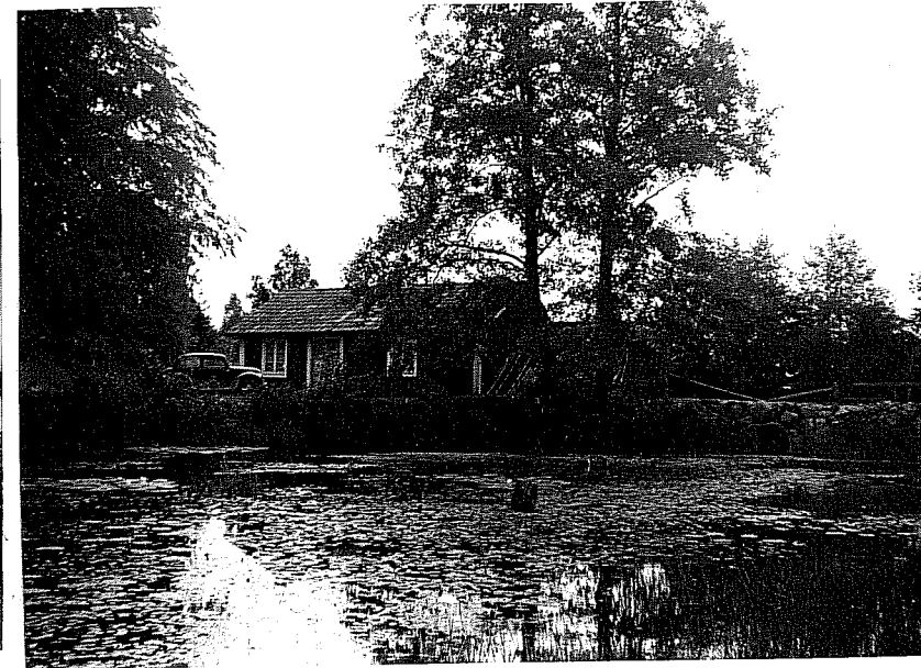
Kvarn- o. boms- huset vid vattenså- gen i Frostusmåla. Dammen i för- grunden (nu om byggverden.)
